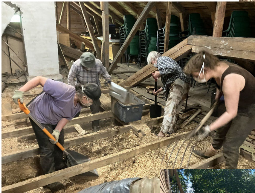
Puruja poistettiin imurilla sekä lapioimalla
