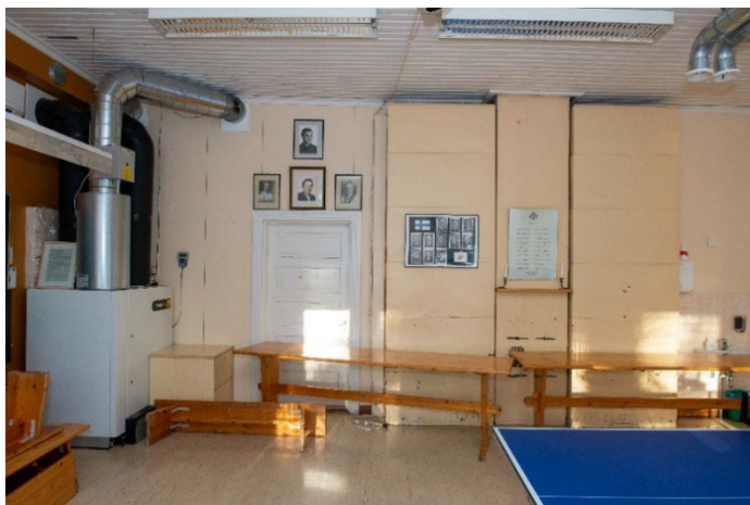
Entinen yläluokan länsipuoleinen väliseinä, jossa ilmastointikone ja uunit
