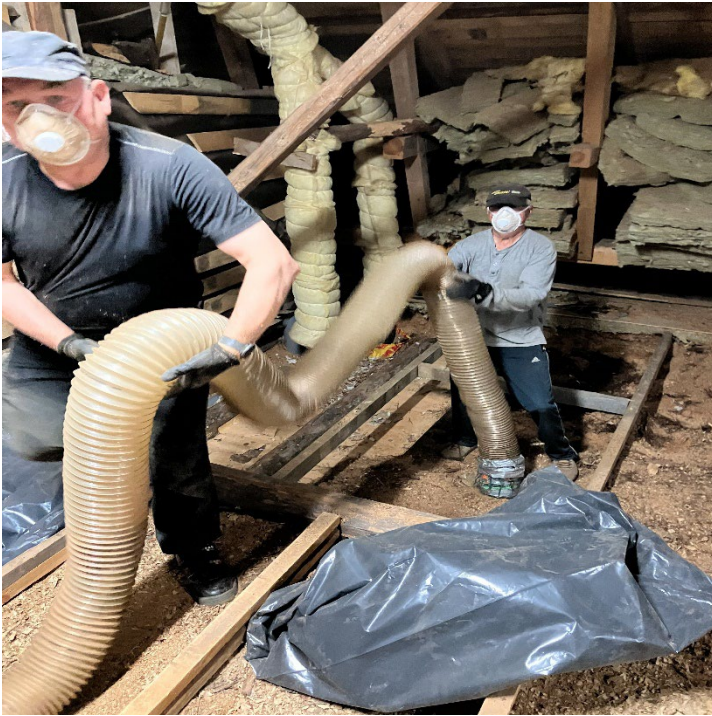
Puruja poistettiin imurilla sekä lapioimalla
